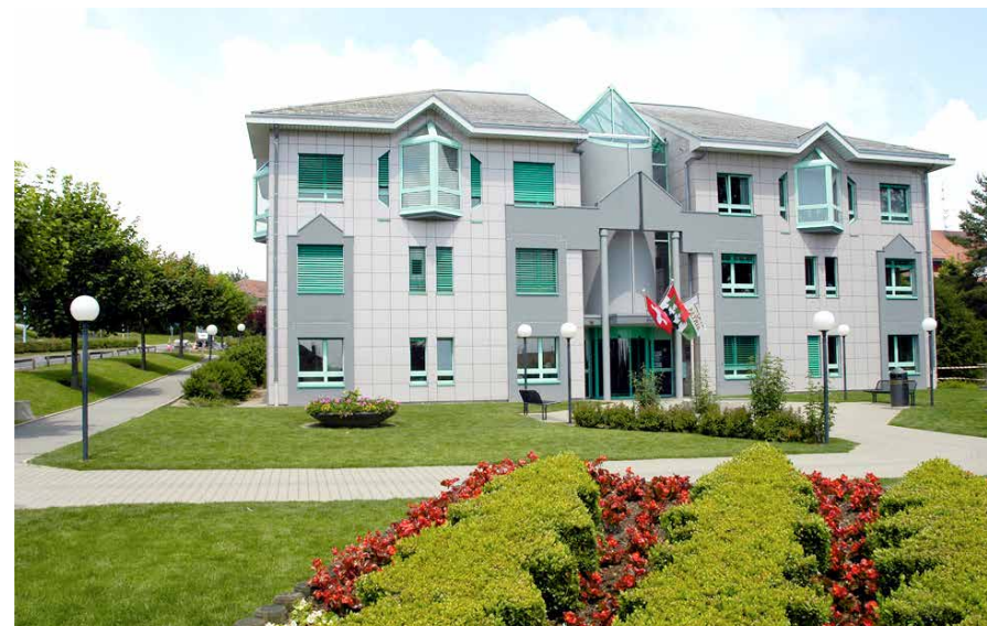
La maison de commune de Savigny : une architecture extérieure et intérieure des plus originales.
